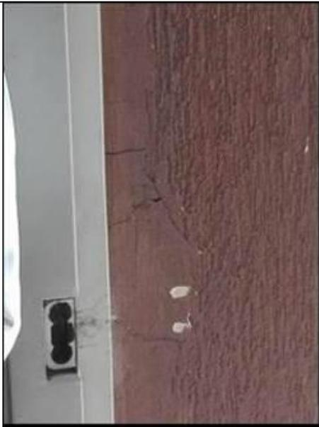
Foto 6. Fisura Longitudinal
